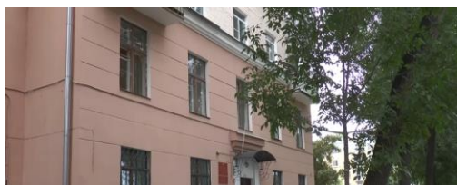
Здание школы по Волжскому проспекту, 43
